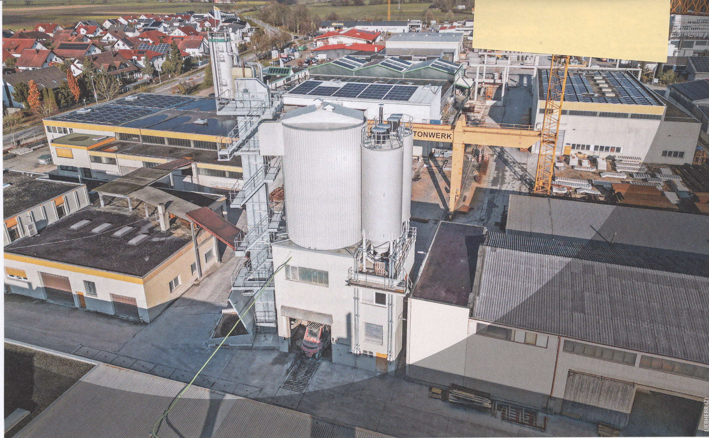
Die Liebherr-Mischanlage vom Typ Betomat 3 mit Ringtellermischer liefert anspruchsvolle Betonsorten.
